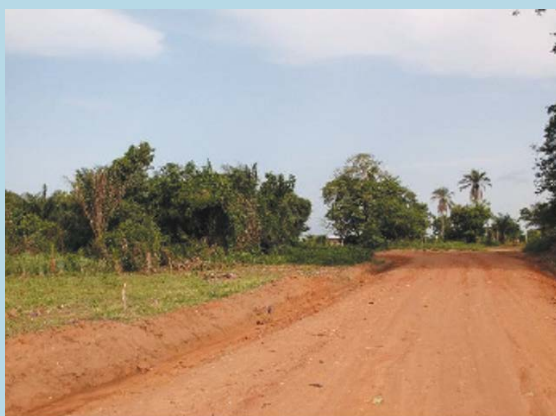
Une piste réhabilitée au Togo. Source République du Togo.
