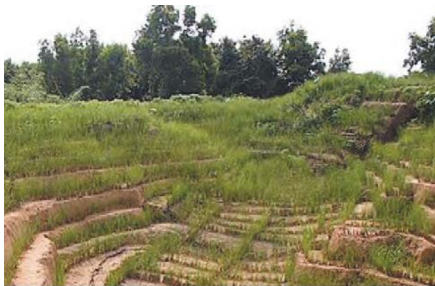
Stabilisation des pentes par la végétalisation à côté d'une route. 14
