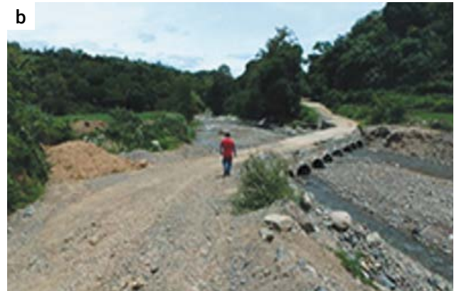
Un radier busé plutôt qu'un pont : (a) avant travaux, (b) un an après la fin des travaux.
