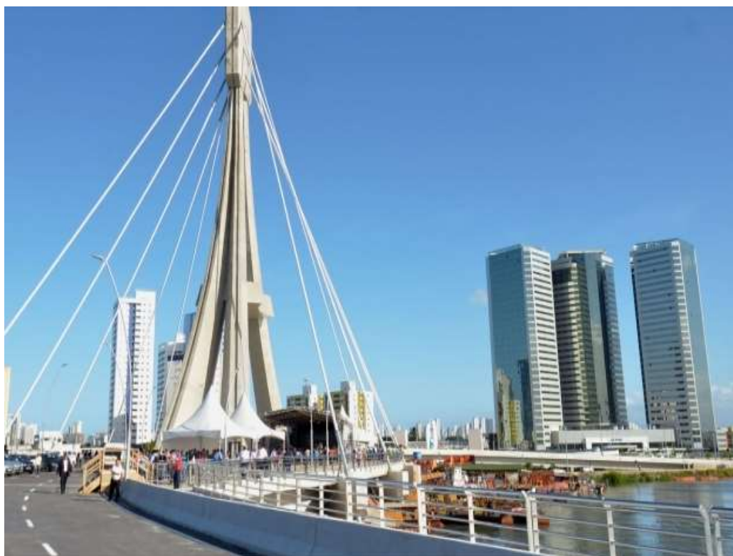
Figura 09 – Vista da ponte estaiada da Via Mangue, em que aparece ao fundo o Shopping Riomar com suas três torres empresariais. Fonte: http://www1.leijaja.com/noticias/2014/06/19/mangue-tra-jeto-em-sete-minutos-50kmh/ , acesso em 27/07/2014.
