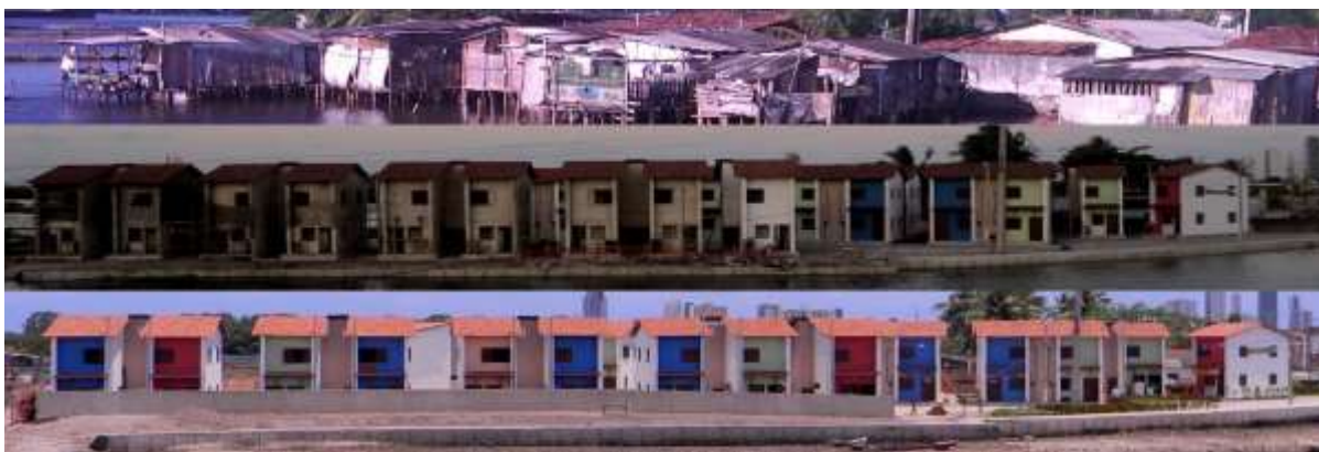
Figura 15 – O assentamento Ilha de Deus em imagens antes, durante e depois da implantação do projeto de urbanização integrada, conduzido pelo Governo do Estado de Pernambuco. Fonte: Apresentação realizada pela Secretaria de Planejamento e Gestão do Governo do Estado.
